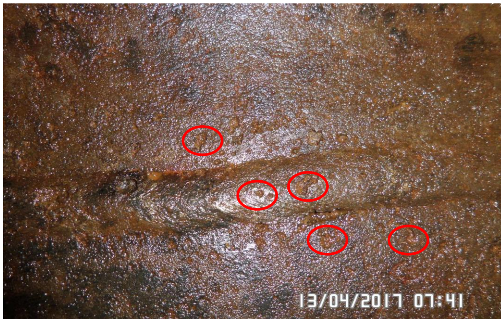
Figuur 5-1: putcorrosie dieseltank Woudenberg
