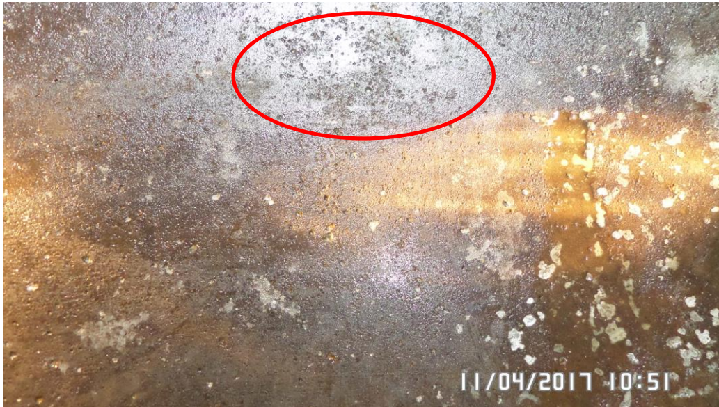
Figuur 5-2: putcorrosie dieseltank Enter
