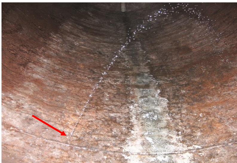
Figuur 1-1: Lekkage in tankwand t.g.v. corrosie
